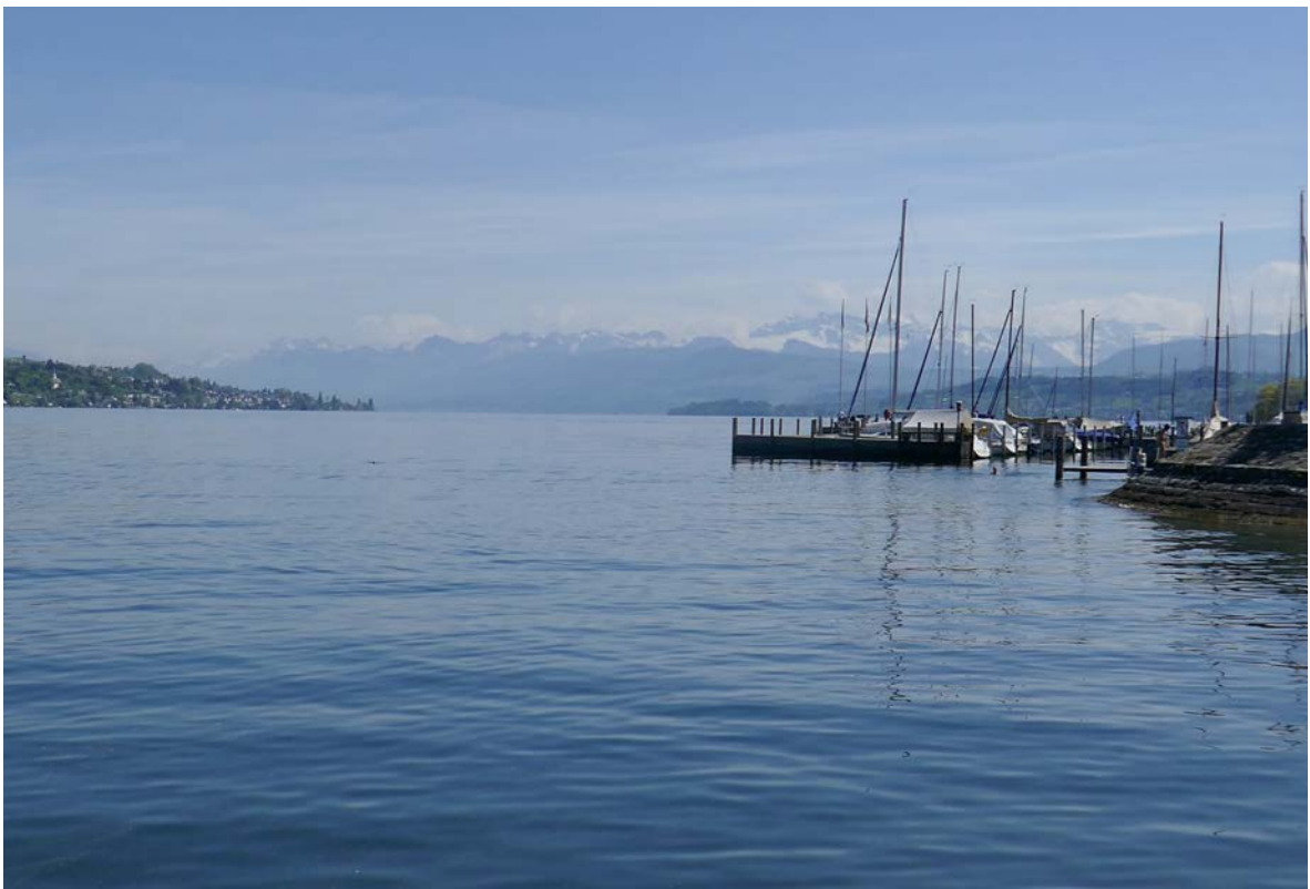
Abb. 17: Blick auf die südliche Mole des Hafens Farbsteig
