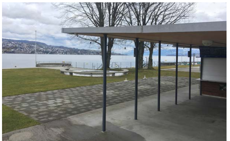
Abb. 6: Garderoben- und Kioskgebäude Strandbad Bürger II
