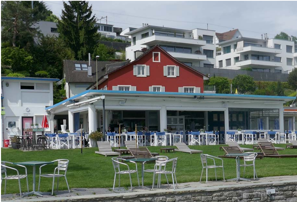
Abb. 25: Eingang und Restaurant «The Beach» im Strandbad Bürger I
