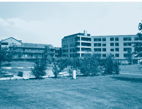
Krankenhaus Thalwil, von Süden (1975)
