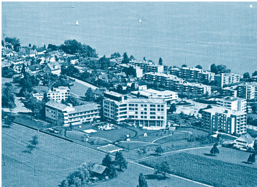
Krankenheim und umgebautes Krankenhaus (1976)
