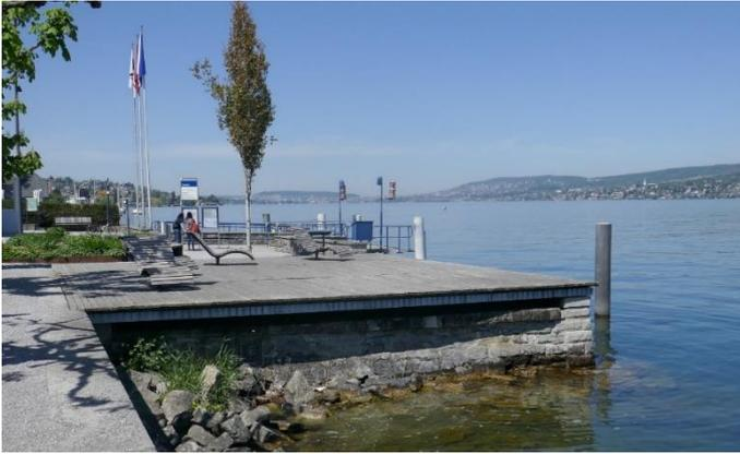
Eine Erweiterung des Bootshafens Farbsteig Richtung See bedingt, dass der Schiffsteg der Zürichsee-Schiffahrtsgesellschaft (ZSG) verlängert wird, weil sonst die Schiffe aufgrund eingeschränkter An- und Abfahrtsrouten sowie Manövrierfähigkeit nicht mehr bei der Schiffstation Thalwil anlegen könnten. Die Verlängerung des Schiffstegs entspricht etwa der geplanten Erweiterung des Hafens Richtung See. Es wird von ungefähr 26 Metern ausgegangen.
