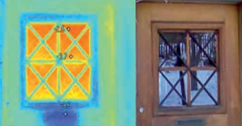
**Foto: Thermographieaufnahme der Haustüre (rechtes Foto) eines älteren Thalwiler Zweifamilienhauses. Die Farben im linken Bild bedeutet: blau = kalt, rot = warm. Dies ist beim einfach-verglasten Türfenster klar ersichtlich, orange bedeutet hohe Wärmeverluste (eigene Aufnahme Januar 2009 bei minus 9°!)**
