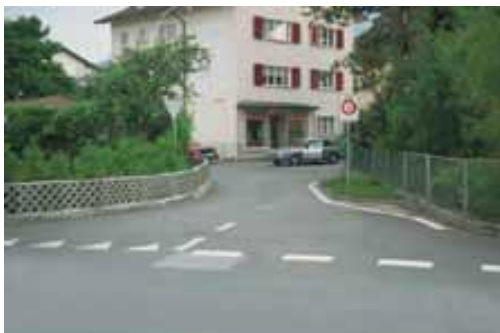
Torelement zu Beginn der Tempo-30-Zone
