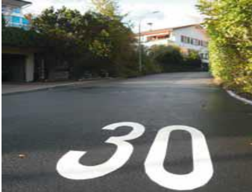
Wiederholt Tempo-30-Signete auf der Fahrbahn
