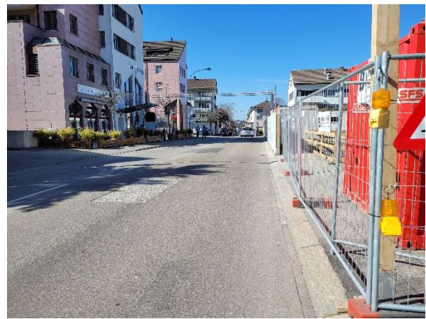
Abbildung 4: Gotthardstrasse (Höhe künftige Bushaltestelle)
