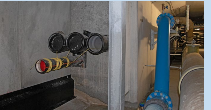
In beiden Tunnelröhren sind neben dem Werkleitungskanal bereits Leerrohre für die Kabel der Höchstspannungsleitung vorhanden.
