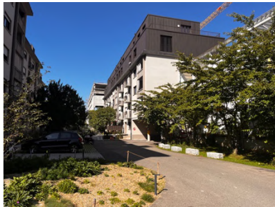
Aufstockung Gebäude, Volta Nord, Kanton Basel-Stadt Quelle: SKW
