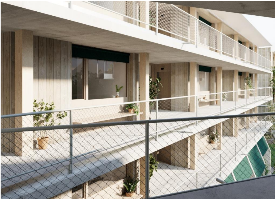
Abbildung 10 Ansicht Laubengang, TEN WORKS AG.
