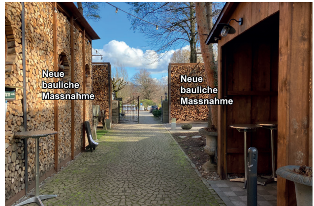
Neue bereits erstellte bauliche Massnahmen in Ausbreitungsrichtung Nord-ost / Blickrichtung Nordost
