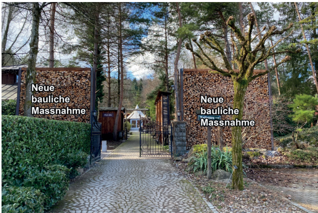
Neue bereits erstellte bauliche Massnahmen in Ausbreitungsrichtung Nord-ost / Blickrichtung Südwest
