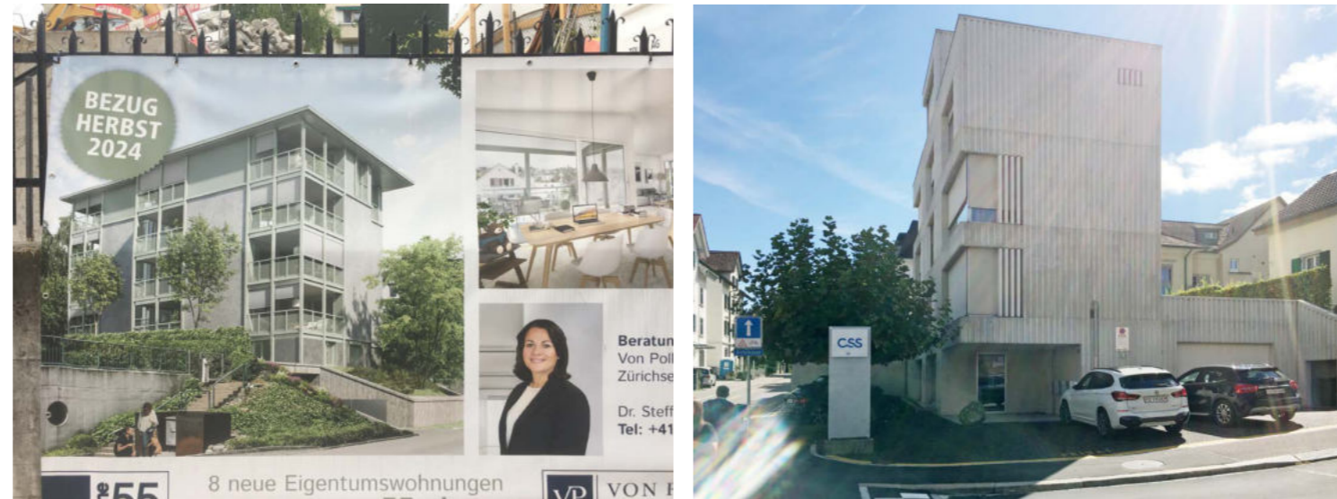
Unklar definierter Räume zwischen Trottoir und Fassade
