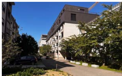
Aufstockung Gebäude, Volta Nord, Kanton Basel-Stadt Quelle: SKW
