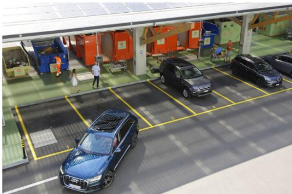
Abbildung 3: Entsorgungsparks für die Gemeinden im Verbandsgebiet EZI, in Adliswil (oben links), Horgen (oben rechts) und Wädenswil (unten links)
