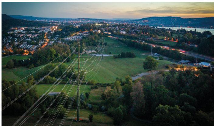
Erleben Sie die Bauarbeiten zwischen Sihlhalden und Kilchberg.
